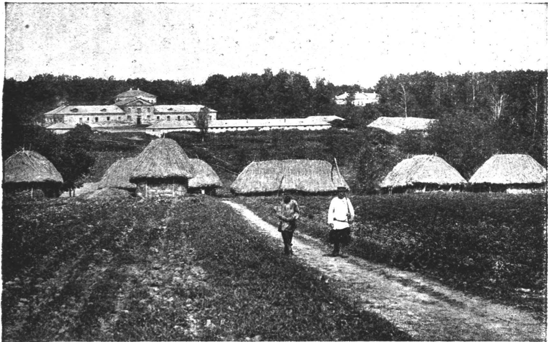
Общий вид усадьбы. На первом плане так наз. дом Волконского, за ним флигель, главный дом правее, среди деревьев парка.
